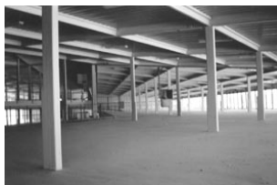
Металлоконструкции в гараже на ул. Лобачевского в Москве окрашены составом МПВО
